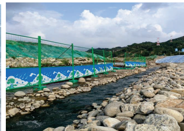
圍堰內滲流水導排
