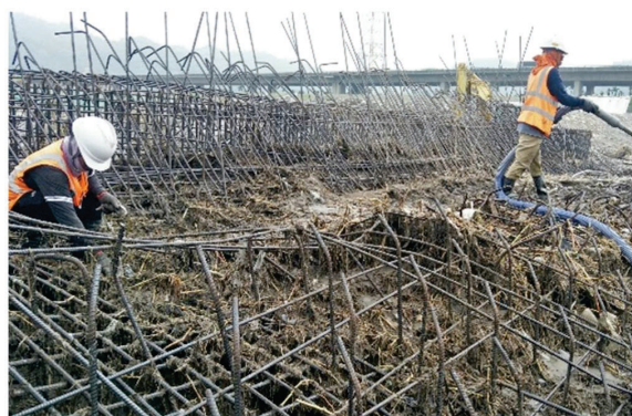
大水後鋼筋重新綁紮
