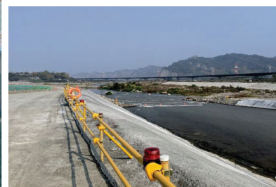
設置臨時快速導水路
