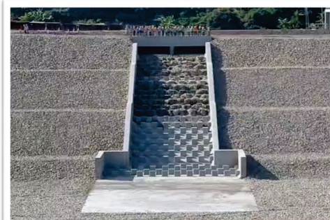
如期完成第一階段供水
