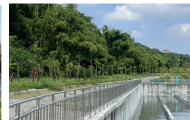
引水設施工程沉砂池
